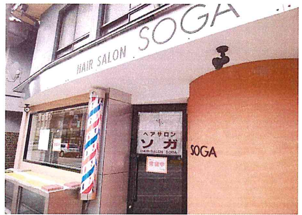
↑新しく設置した蛍光サインポール
